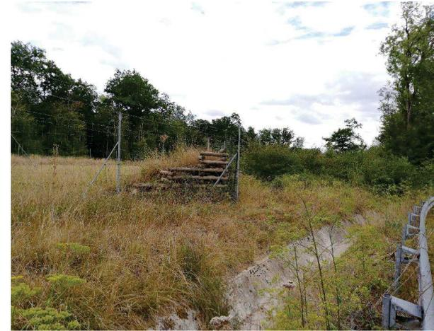
Figure 123 Échappatoire en rampe sur la LGV Est Européenne (Photo ©Egis)
