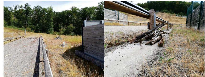
Figure 128 : Deux passages supérieurs mixtes forestier-faune, fonctionnels sur la LGV Est européenne : banquette enherbée spécifique pour la faune, palissade, glissière et plantations aux abords (Source : Egis)
